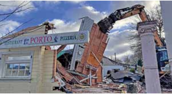
Ende Januar wurde das ehemalige Restaurant Porto abgerissen. Foto: Thomas Krohn
