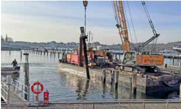
In monatelanger Arbeit wurden die alten Holzdalben aus dem Hafenschlick gezogen.
