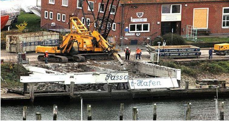
Abriß von Fundament und Arbeitsfläche des Hafenkrans.
