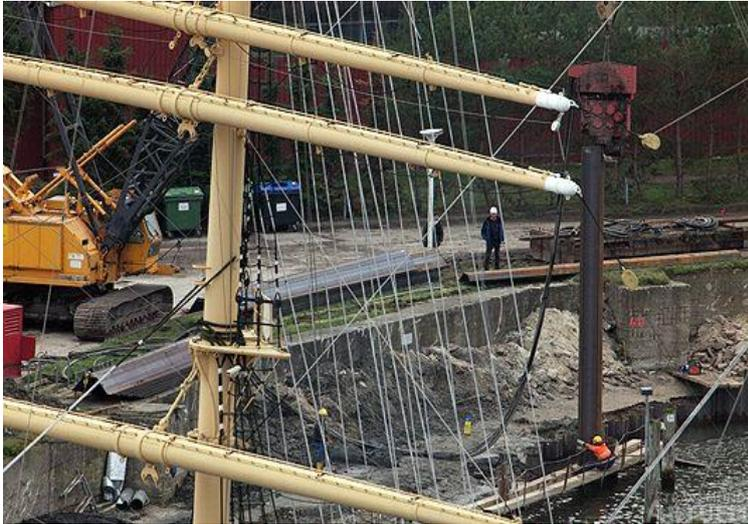
Rammen (durch Vibration) der Stahlspundwände
