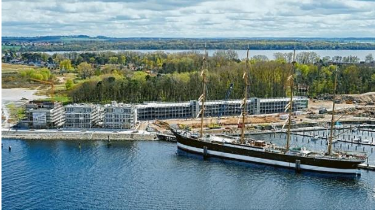
Großbaustelle Priwall Waterfront: Links die Dünenvillen, rechts das riesige Parkhaus (Fotos: Hn)
