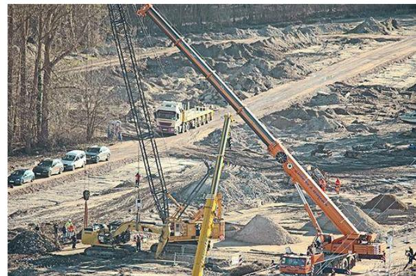
Schnell hob sich der Delinquent nach oben und fein aufeinander abgestimmt hievten ihn die beiden Kranführer zur Seite. Plötzlich ein Krach und das um den Greifarm des Baggers gelegte Textilband riss. Der Bagger befand sich in sehr geringer Höhe, so dass nur seine Baggerschaufel mit laut hörbarem Krach aufsetzte. Schnell war ein Drahtseil um die Baggerschaufel gelegt und die Bergung nahm ihr glückliches Ende. Kurz nach 15 Uhr war die Arbeit getan. **KEV**
