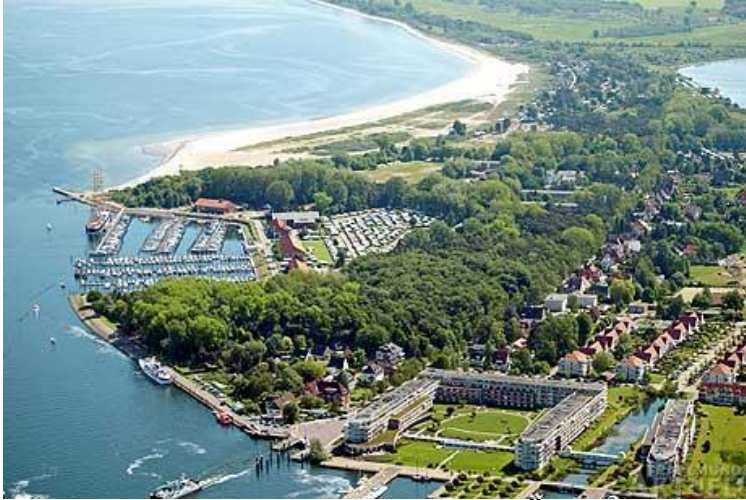
Der Priwall. Foto: KARL ERHARD VÖGELE
