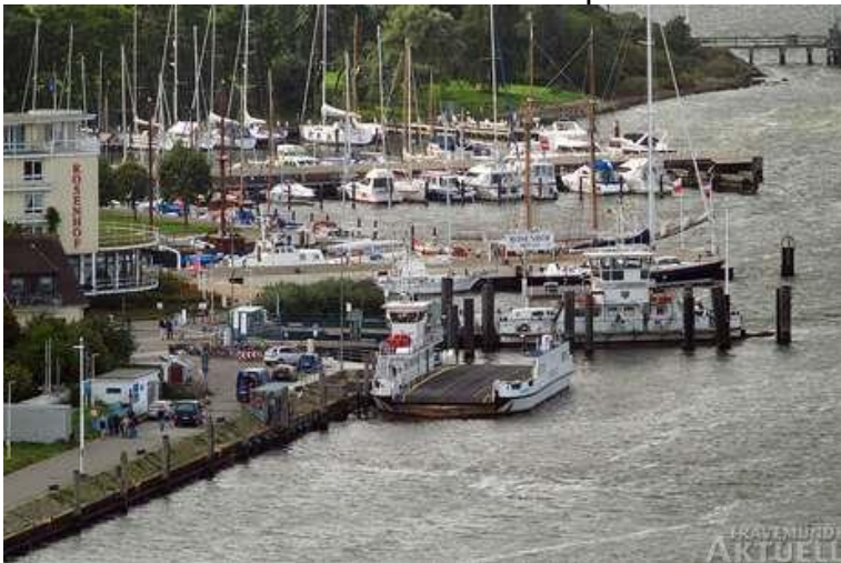
Die Reparatur-Arbeiten an der »Pötenitz« haben bereits begonnen. Fotos: KARL ERHARD VÖGELE
