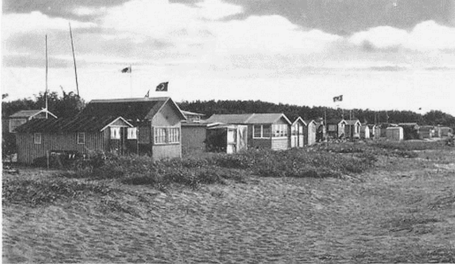
Offenbau Priwall Travemünde
