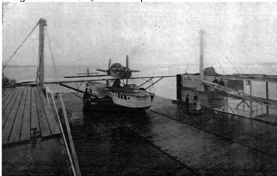
100 t Schwimmdock für Flugzeuge. Erbaut auf dem Lübecker Flender-Werf. Photogr. Herm. Feldt.
