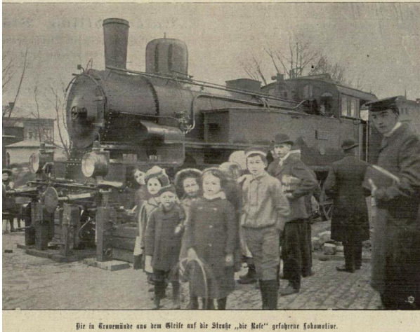
Hier in Travemünde aus dem Gleise auf die Straße „die Rose“ gefahrene Lokomotive.
