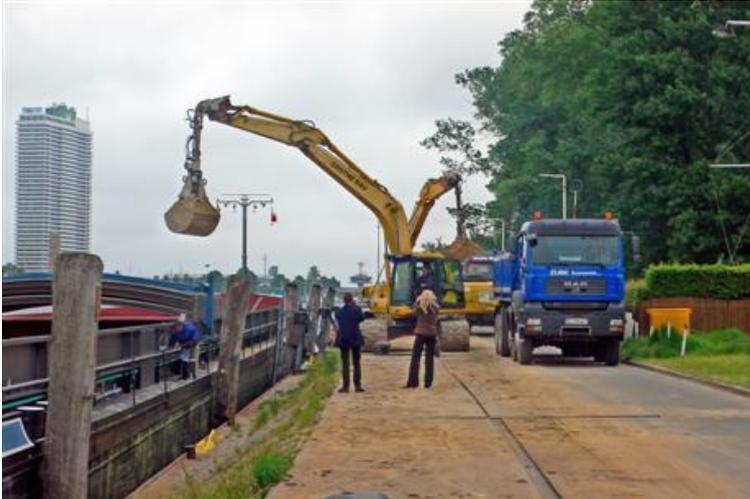
Zwei Bagger heben gleichzeitig den Sand in die Laster.
