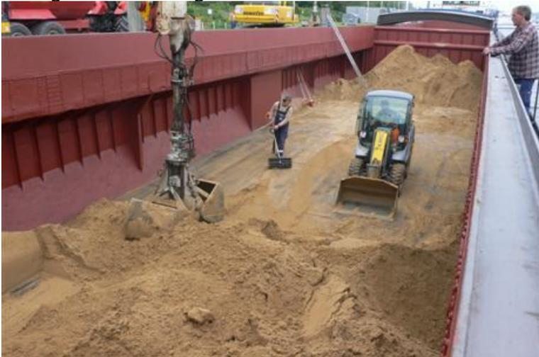
Im mächtigen Schiffsbauch schiebt der Schaufellader den Sand zusammen, damit ihn der Bagger gut fassen kann. Derweil fegt eine kleine Kehrmaschine die Reste zusammen. Rechts im Bild der Sandhaufen für den zweiten Bagger.
