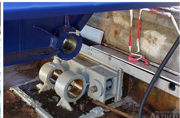
Die Hauptklappe wurde nunmehr landseitig auf Holzbohlen in Höhe der Lager abgelegt. Zum weiteren passgenauen Einfügen ins Lager musste die Hauptklappe am anderen Ende in ihre endgültige Aufhängung an den beiden Hubtürmen eingefügt werden. Dies ist zwischenzeitlich geschehen. Dadurch gab es mehr Spielraum für weitere Justierungen. So konnten schließlich die Lagerbolzen eingefügt und die Hauptklappe damit vertikal beweglich in den Lagern an der Kaikante eingehängt werden.
