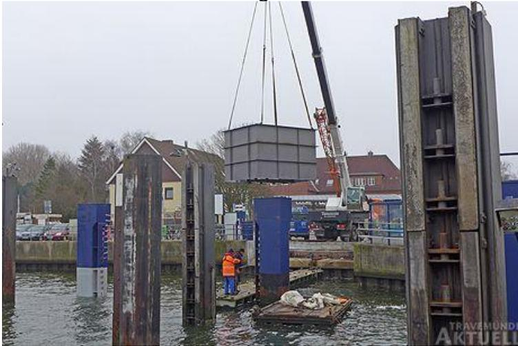
Ein Kasten wird über die Dalben abgesenkt und nach unten abgedichtet. So ist es möglich, den Dalben auch ein Stück unter Wasser zu streichen und verstärkende Metallplatten anzuschweißen. Die längere Vorrichtung am Kranseil wird in das Innere der Dalben eingelassen. An einem über ein Rad geführtes Seil wird später die Anlegerklappe eingehängt. So kann deren Höhe in Abhängigkeit vom Wasserstand auf und abgefahren werden. Fotos: **KARL ERHARD VÖGELE**
